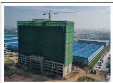
在建新办公楼
